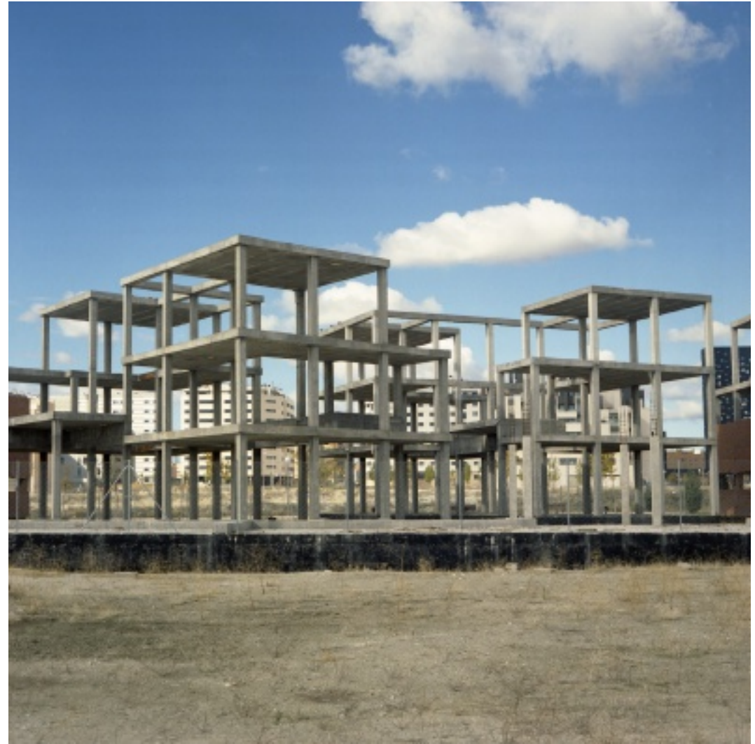
Edificio parado #07 photographie argentine, 2011
