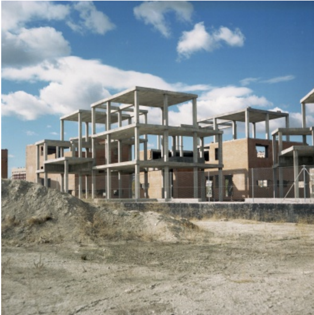
Edificio parado #06 photographie argentine, 2011
