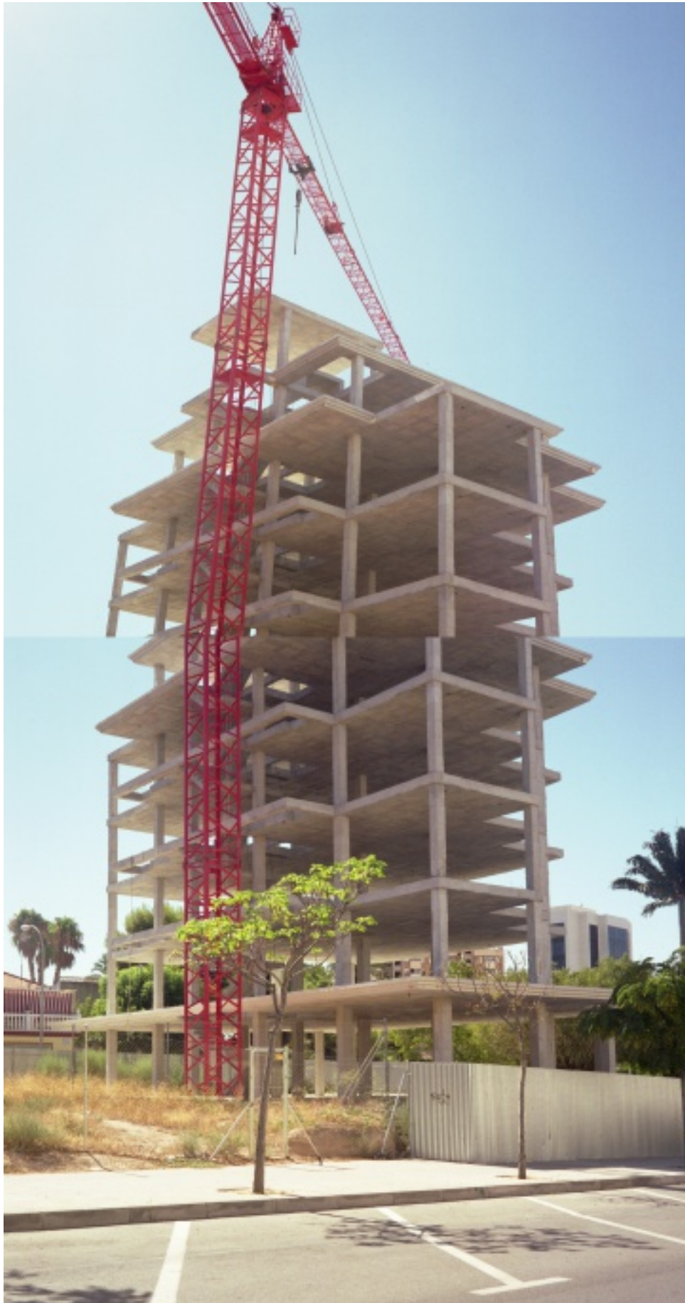
Edificio parado #04 photographie argentine, 2011
